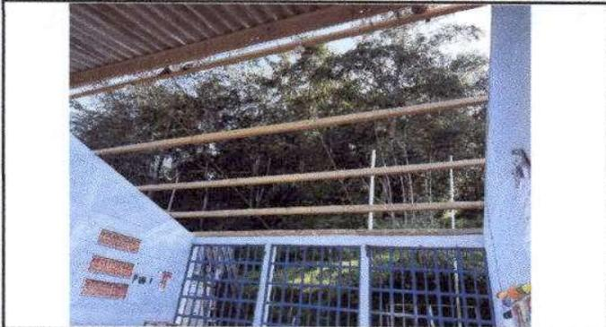
Foto 1: Aula 1: Sustitución de lámina, por lámina aluzinc calibre 26, Fabricación e instalación de ventanas de metal
