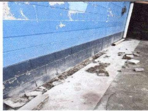
Foto 16: Reparación de bajada de agua pluvial y conducción bajo tierra de canal.
