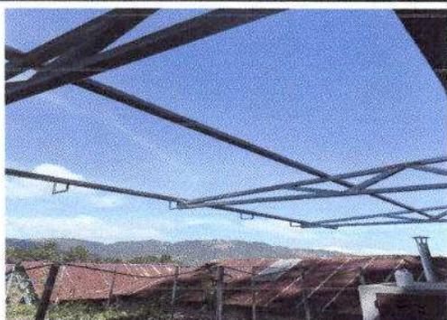
Foto 7: Corredores de sanitarios (Cubierta de lámina, Estructura de techo, sustitución de piso de tierra por torta de cemento)
