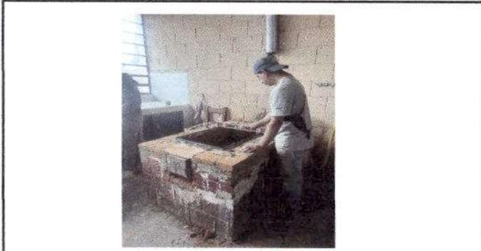
Foto 3: Sustitución de estufa rural (completa) incluye chimenea y plancha de metal, instalación de azulejo en estufa rural) área de cocina
