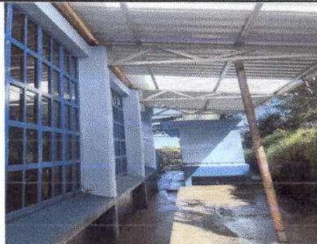
Foto 8: Corredor de sanitarios: Sustitución de canal de pvc, Sustitución de bajada de agua pluvial de metal por tubo PCV 3''
