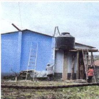
Foto 17: Reparación de cisterna de agua y construcción de tarima de concreto para sostenerla.
