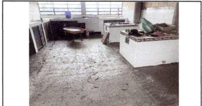
Foto 4: Cocina (Sustitución de piso cerámico, Reparación de azulejo en muebles de cocina)
